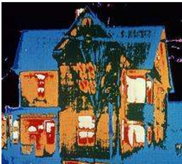
►Un termograf arată marea cantitate de caldura pierduta prin ferestrele unei case în timpul iernii. Înlocuind clasicele ferestre cu cele duble sau triple se reduce volumul de caldura eliberata. Acestea conservă energia și reduc facturile pentru caldura.
