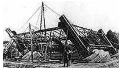
Construction d'une des piles
